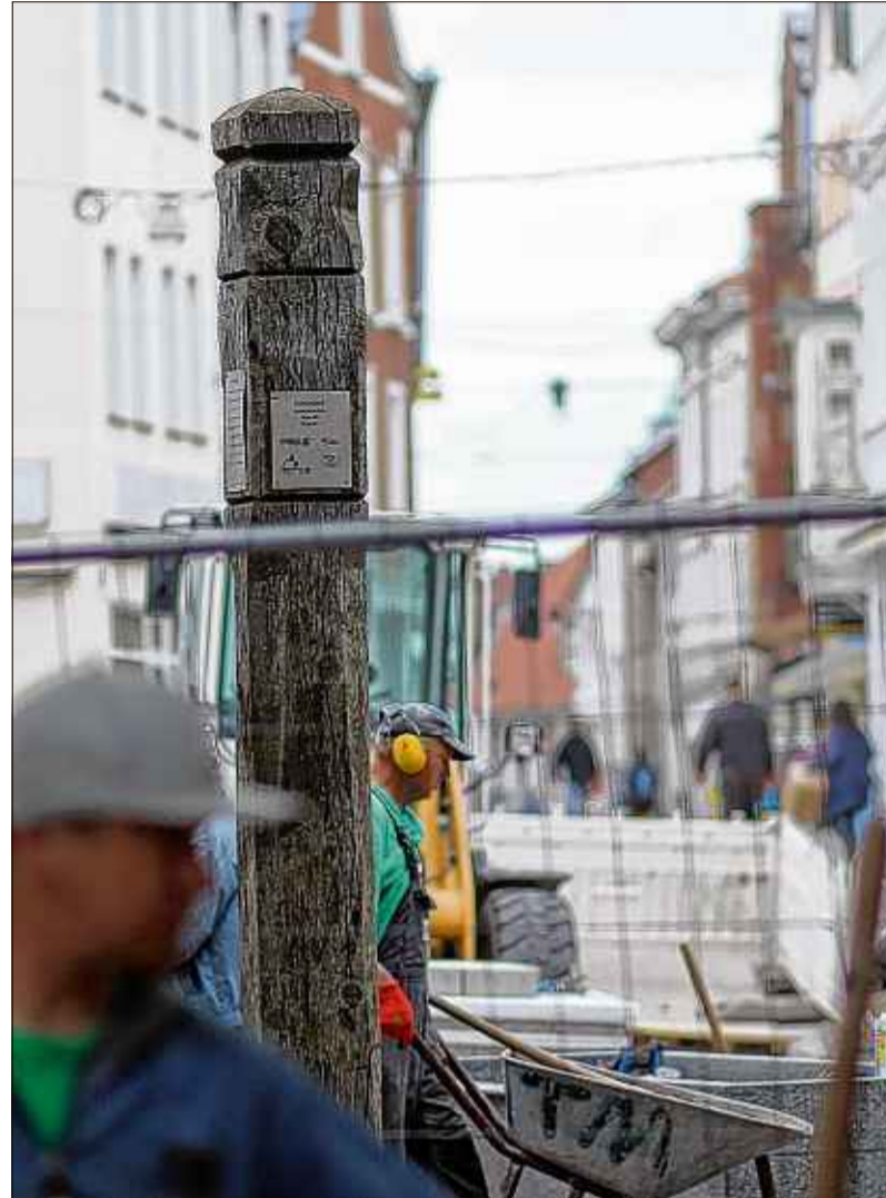
Zum Abschluss der Arbeiten steigt die letzte Baustellenparty am morgigen Donnerstag, 18. Mai. MT-Foto: Alex Lehn
